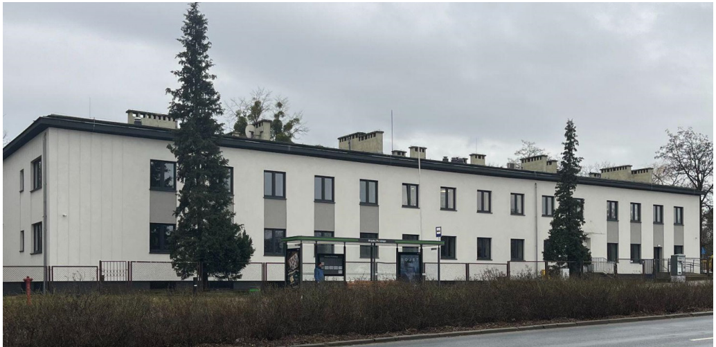
Zdjęcie 8: Budynek szkół Spark Academy przy ulicy Wojska Polskiego 53 w Poznaniu.
